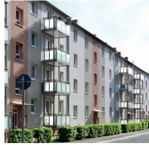
Energetische Sanierung Fabrikstr. 50-58
