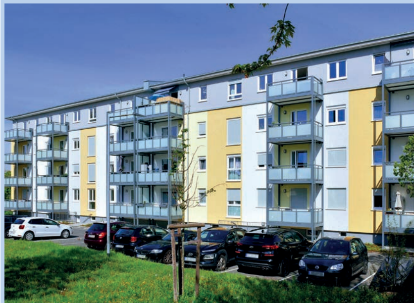
Modernisierung Reigersbergerstr. 15, 17, Rückansicht
