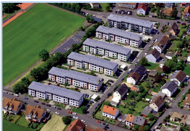
Modernisierung und Aufstockung Finkenweg 1–29
