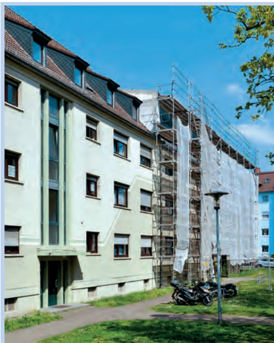
umfassende Modernisierung Spessartstraße 10–12
