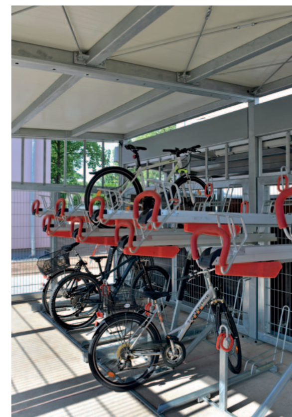
Einhausung Fahrraddoppelparker in Außenanlage Leider
