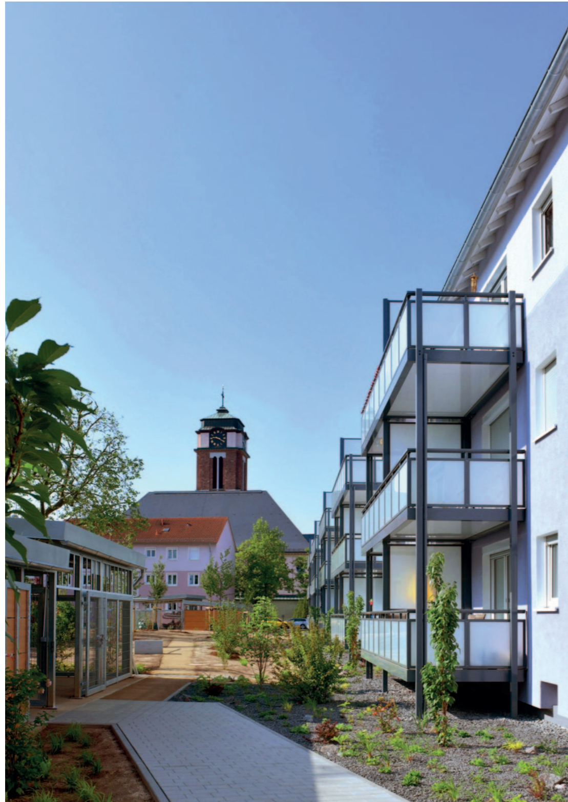
Rückseite Laurentiusstraße 1 – 11 Stadtteil Leider mit neuer Balkon- und Außenanlage
