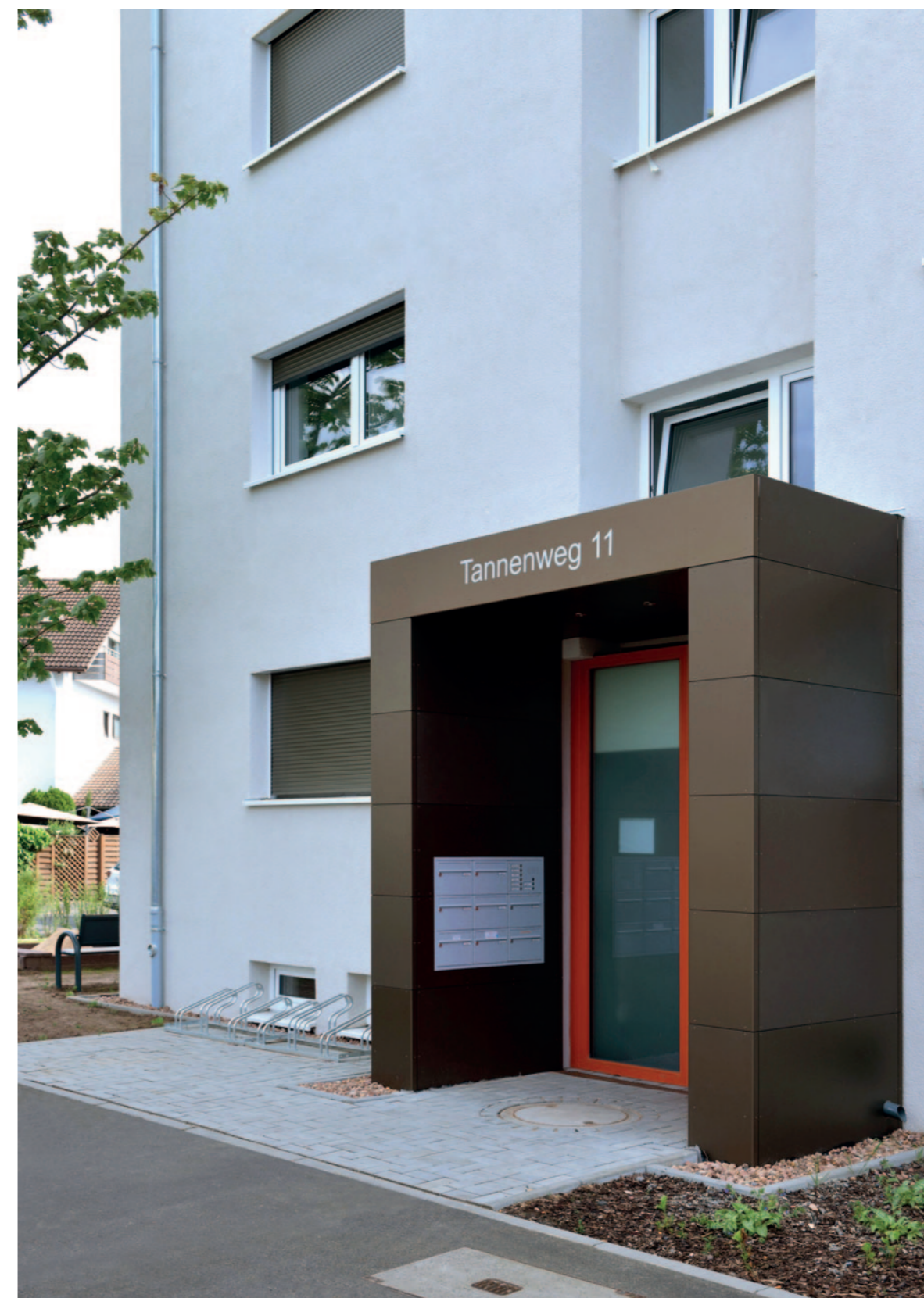
Neugestaltung Eingangsbereich Tannenweg mit integrierter Briefkasten- und Klingelanlage
