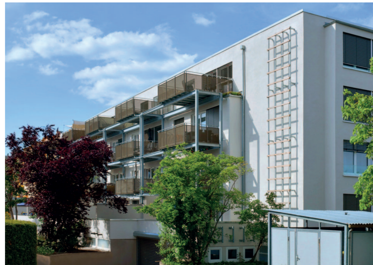
Umbau / Modernisierung Tannenweg 11 – 15 (Stadtteil Nilkheim, 24 Wohneinheiten)
