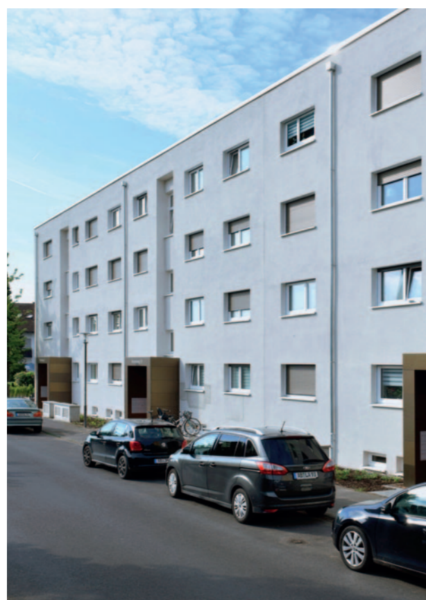
Umbau / Modernisierung Tannenweg 11 – 15
