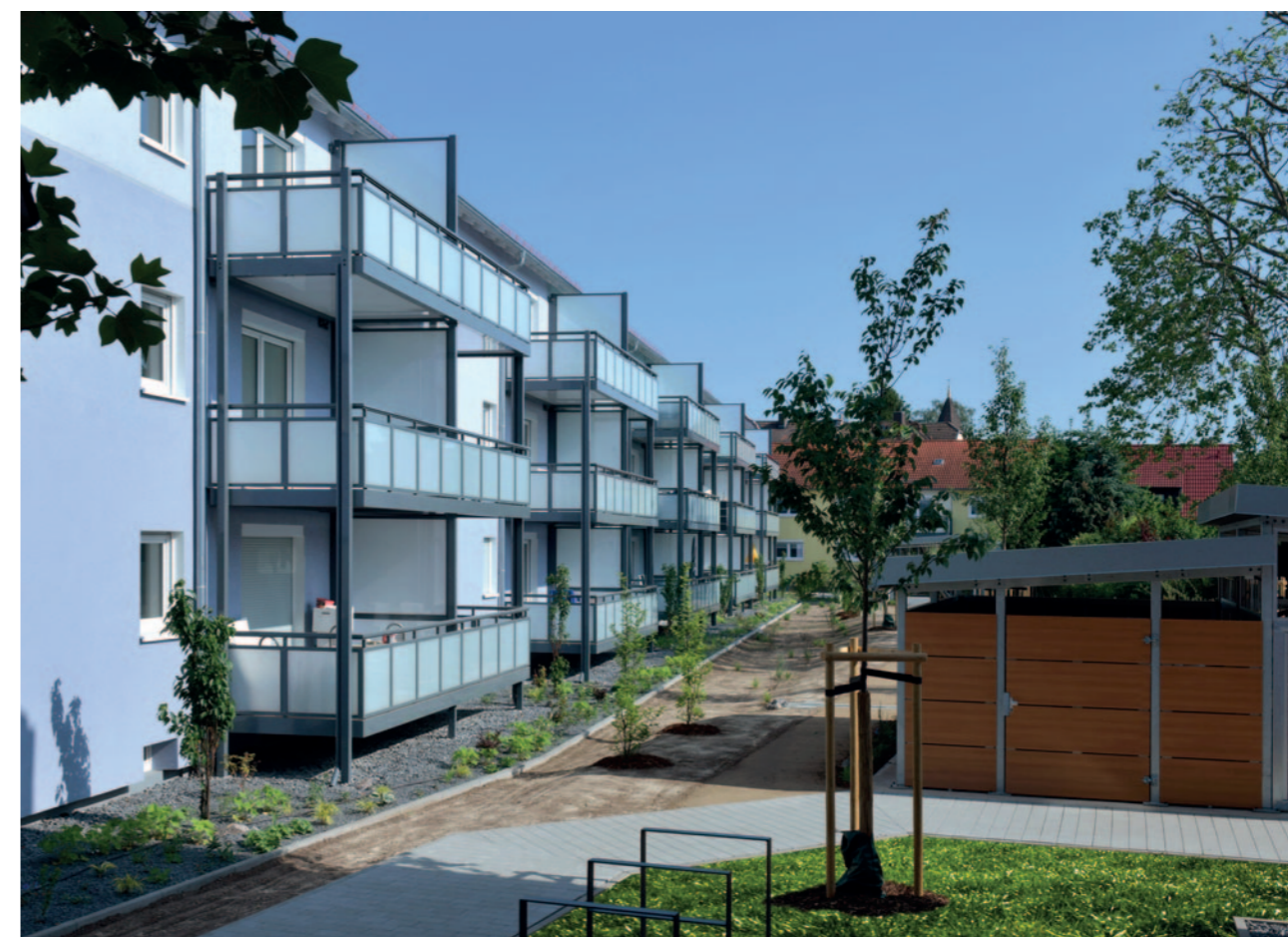
Neugestaltung Außenanlage Stadtteil Leidor (Laurentiusstraße, Leiderer Stadtweg, Friedrich-Krane-Platz)
